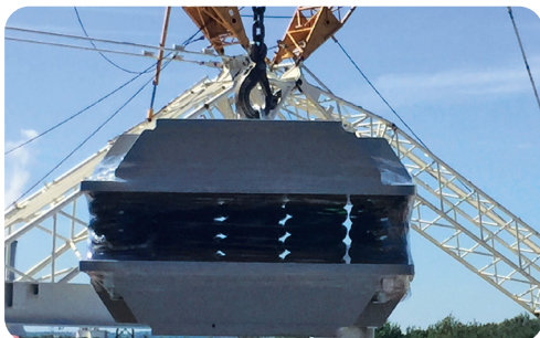
Abb. 3: Hebevorrichtung für Federelement mit Ringschraube
