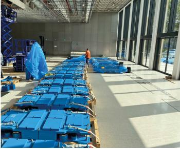
Unter Beibehaltung gestalterischer Vorgaben wurden die Schwingungstilger in den Stahlträgerquerschnitt der Decke integriert. LISEGA SE führte nicht nur Konstruktion und Lieferung, sondern auch die Montage der Tilger in einem sehr kurzen Zeitfenster aus.
