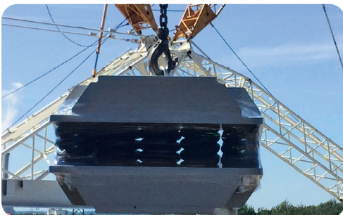
Abb. 3: Hebevorrichtung für Federelement mit Ringschraube
