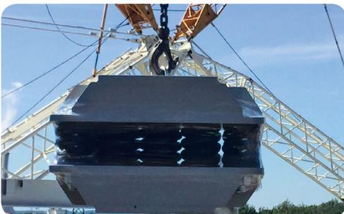
Abb. 3: Hebevorrichtung für Federelement mit Ringschraube
