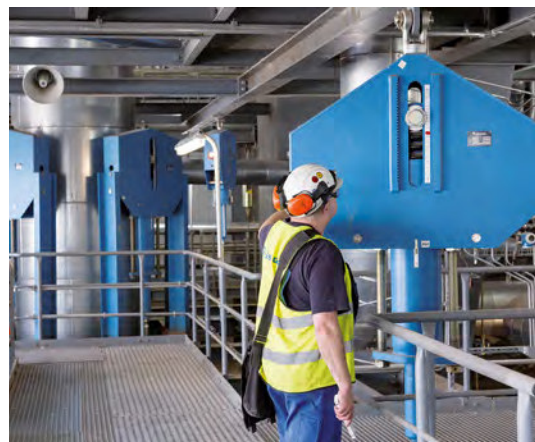
コンスタントハンガーの据付検査
