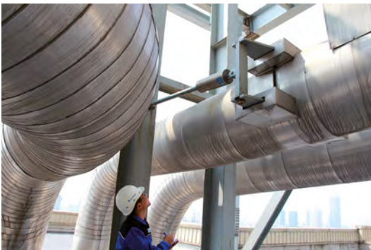
プラントでのサポートの点検
