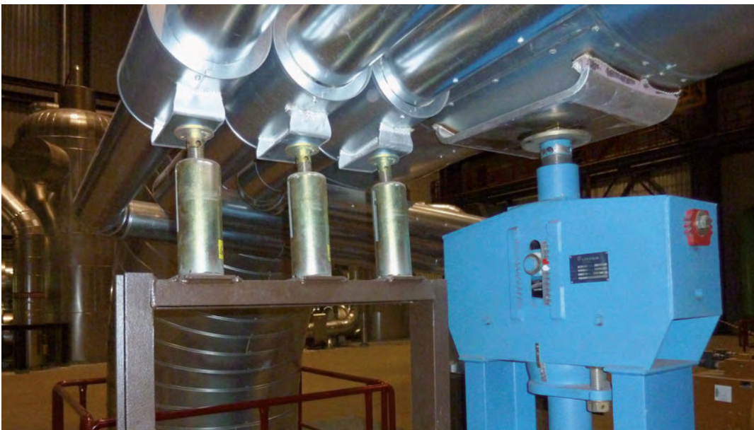
クランプベースの下側に取り付けたスライドプレートの使用例
