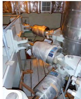
スナバー タイプ 30による配管の安全対策
