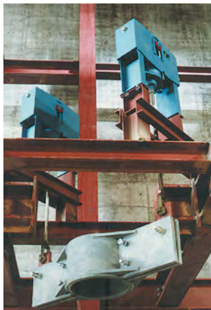
特殊設計のタイプ 45を使った垂直配管用のサポート
