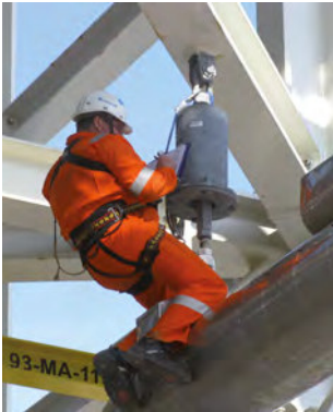
パイプサポートの点検
