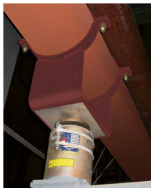
クランプベース タイプ 49の下面に取付けられたステンレス鋼製のスライドプレートと高温度用スライドプレート付きのスプリングサポート タイプ 29
