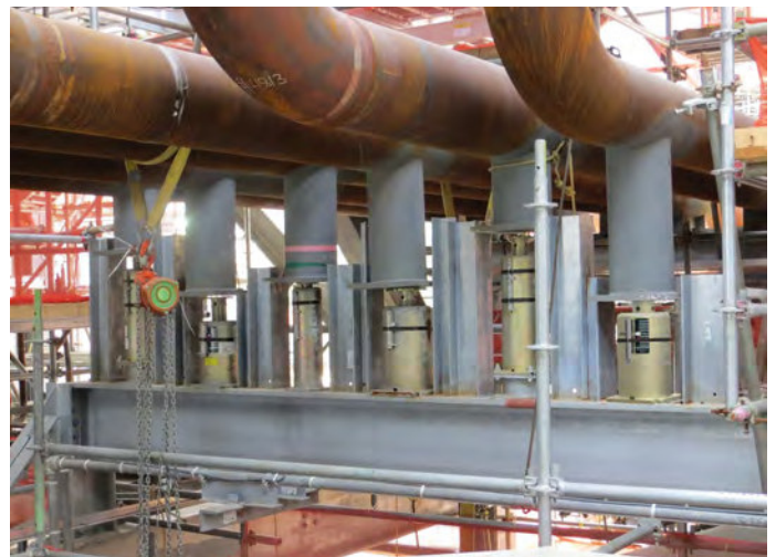
スタンション タイプ 58 水平配管のガイドとしてタイプ 29スプリングサポートと一緒に使用
