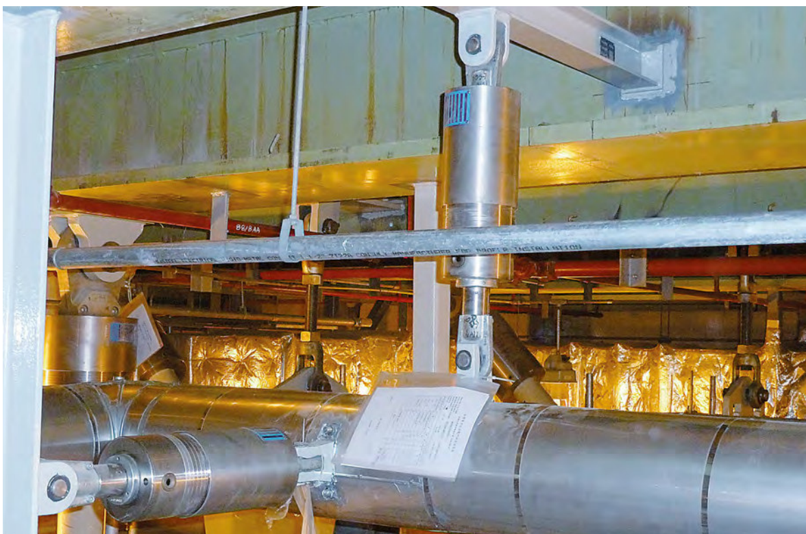
スナパー タイプ 30とダイナミッククランプ タイプ 36を取付けた配管
