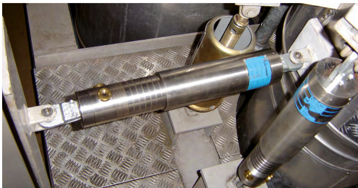
スナバー タイプ 30の取付け例
