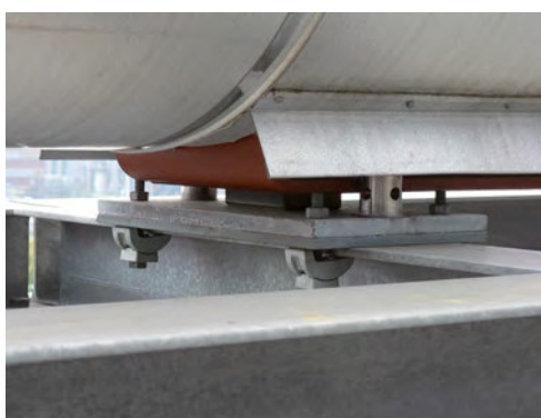
支持構造物にクランプ接続されたスライドプレートの上に設置されたクランプベース タイプ 49
