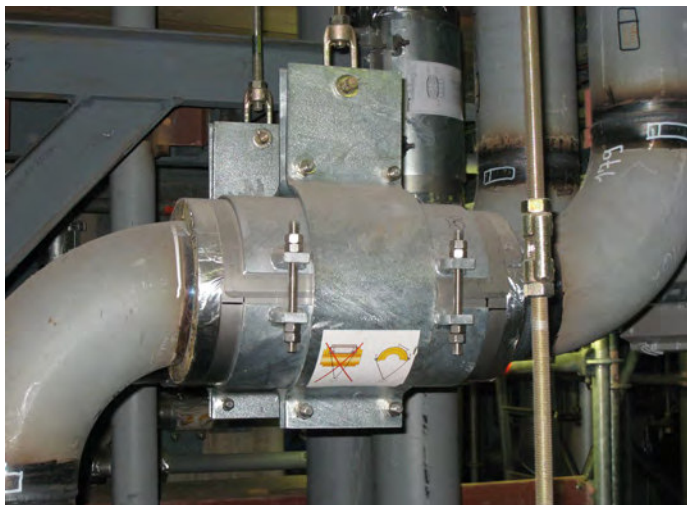
極低温用パイプクランプを使ったハンガー
