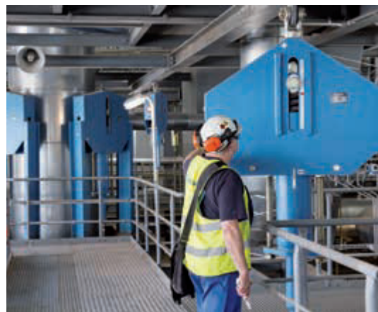
Контроль в процессе монтажа подвески постоянного усилия
