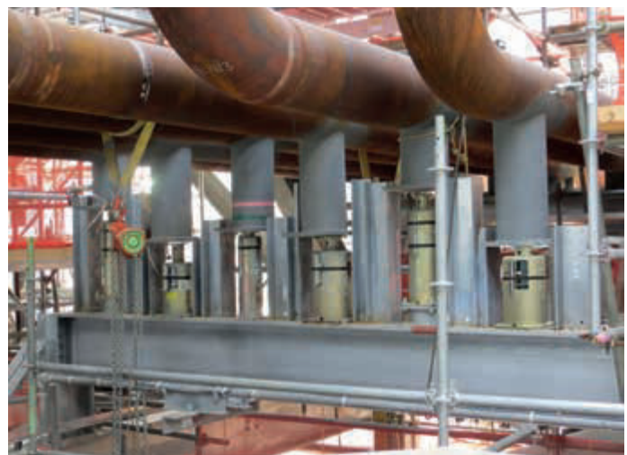
Стойки типа 58 в качестве направляющих опор горизонтальных участков трубопровода с пружинными опорами типа 29
