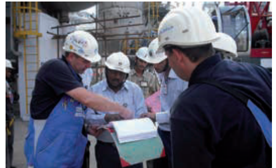
Рассмотрение результатов и наблюдений, сделанных в ходе проверки трубопровода
