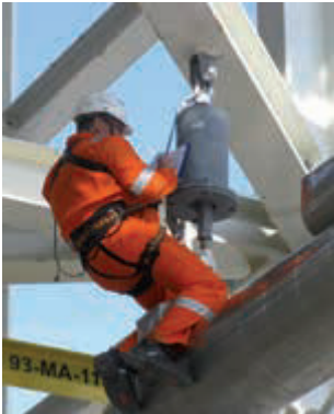
Регулирование опоры трубопровода
