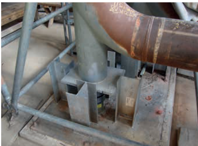
Стойка для колен типа 58 в качестве неподвижной опоры, свободной от моментов относительно осей X-Y с пружинной опорой типа 29
