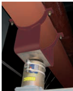
Пластина из нержавеющей стали на основании хомутовой опоры типа 49, термостойкая скользящая подложка и пружинная опора типа 29
