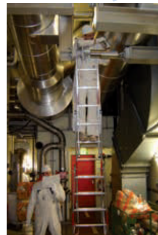
Осмотр ударных стопоров
