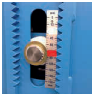
Шкала перемещения с отметкой холодного/горячего положения
