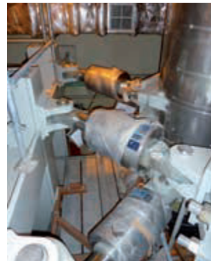
Крепление трубопроводов с ударными стопорами типа 30
