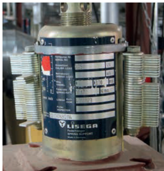
Тип 29 с присоединенными блокировочными устройствами
