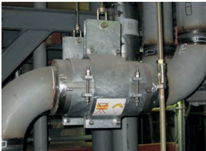
Подвешивание с помощью низкотемпературных трубных хомутов
