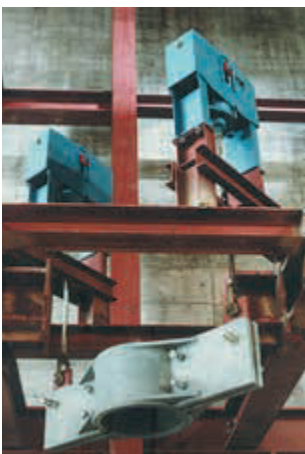
Крепление вертикального звена трубы с помощью специальной конструкции типа 45
