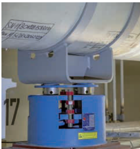
Хомутовая опора типа 49 и пружинная опора типа 28 со скользящими подложками
