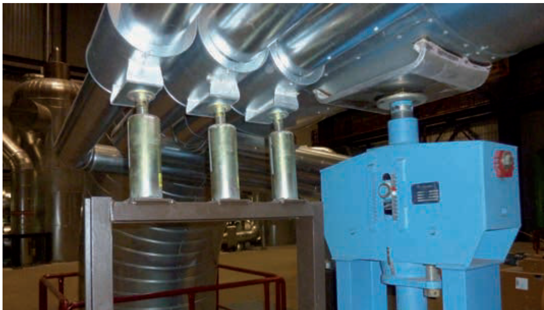
Стандартное использование скользких подложек для хомутовых опор
