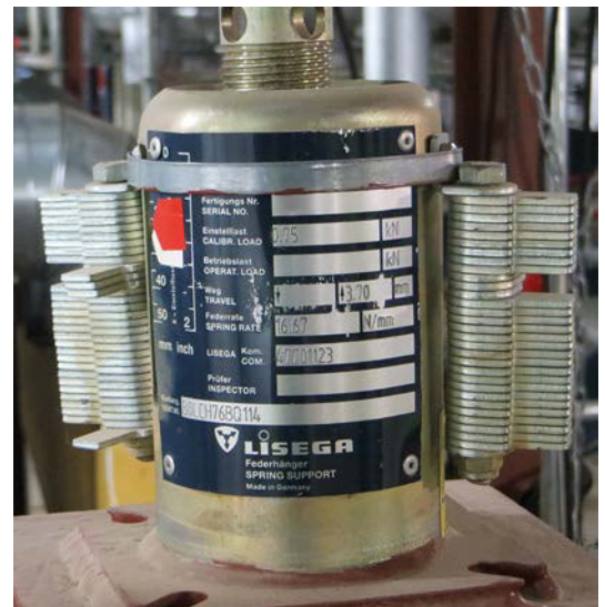
Tipo 29 con dispositivos de bloqueo acoplados
