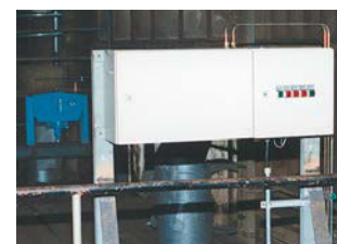
Armario de conmutación de servomuelle
