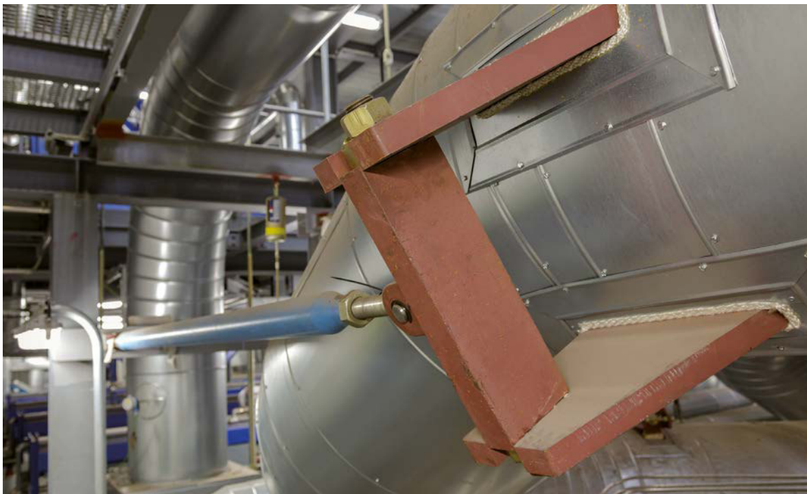
Tope axial horizontal con restricciones mecánicas tipo 39 y abrazadera para tuberías tipo 34
