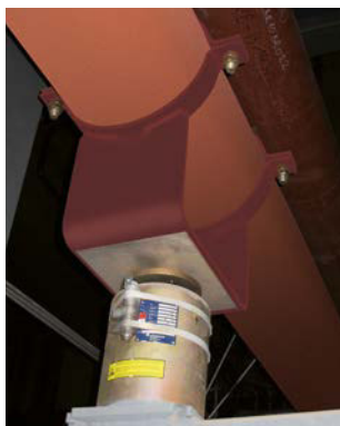
Placa deslizante de acero inoxidable bajo patín tipo 49, placa deslizante para altas temperaturas y soporte de carga variable tipo 29
