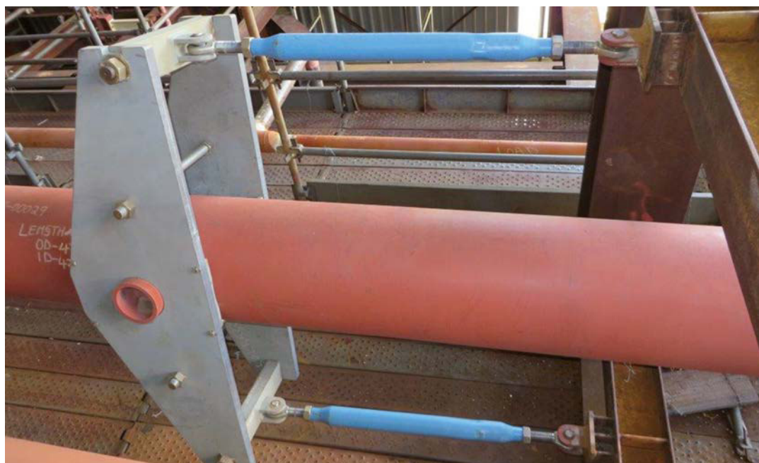
Tope axial horizontal con restricción mecánica tipo 39 y abrazaderas para tuberías dinámicas tipo 34 con espaciador
