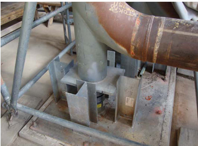
Stanchion tipo 58 para codos de tuberías utilizado como tope libre de momentos en la dirección X-Y con soportes de carga variable tipo 29
