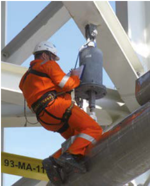
Comprobación de un soporte de tubería
