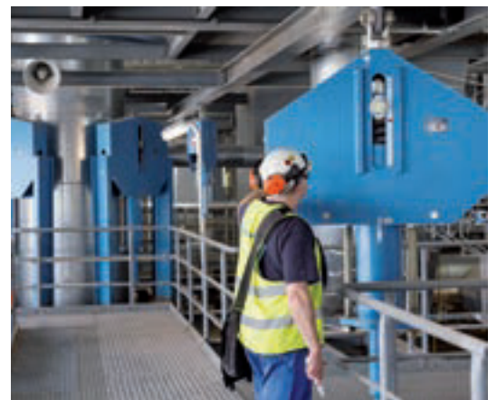
Einbauinspektion eines Konstanthängers
