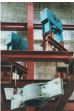
Unterstützung eines Vertikalstranges mit Sonderkonstruktion vom Typ 45
