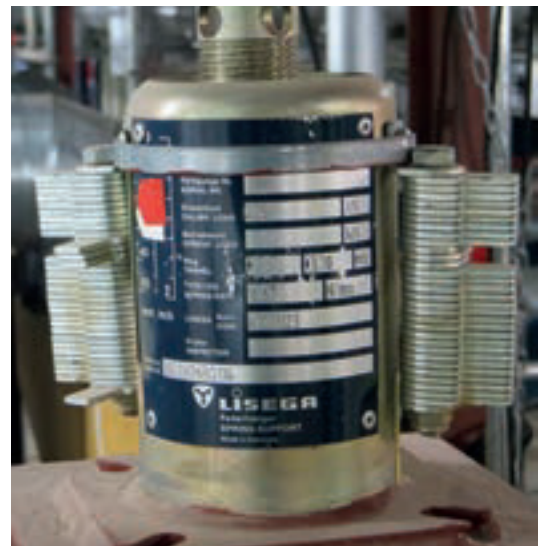
Typ 29 mit Befestigung der Blockierungen
