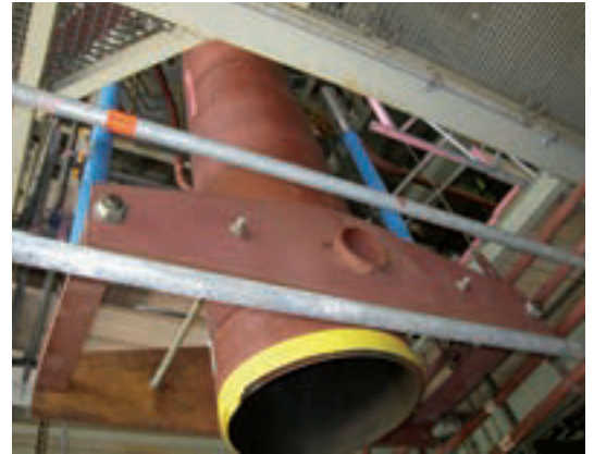
Typ 34 mit Stoßbremsen und Lagesicherung
