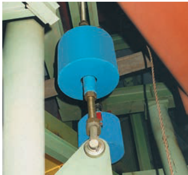
Federhänger Typ 22 mit Gewindebügel Typ 61 montiert
