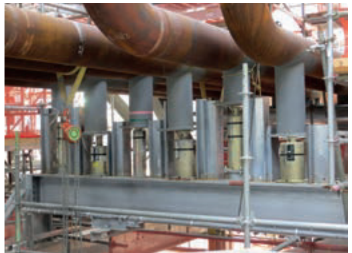
Rohrstützen Typ 58 für horizontal verlaufende Rohrleitungen als Führungen mit Federstützen Typ 29
