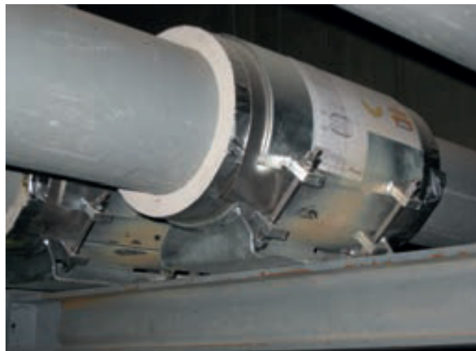
Kälteisoliertes Rohrlager Typ 56
