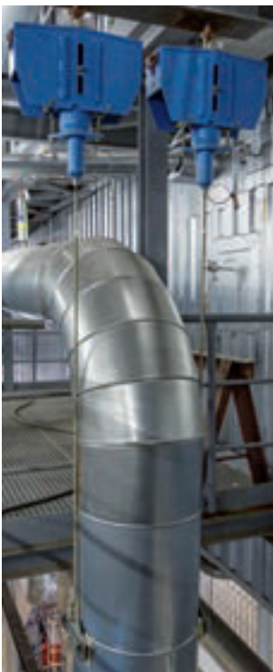
Konstanthänger in einem Kohlekraftwerk
