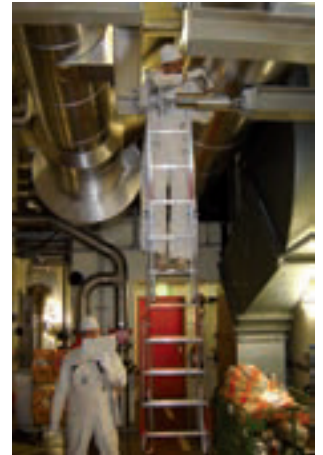
Visuelle Kontrolle von Stoßbremsen
