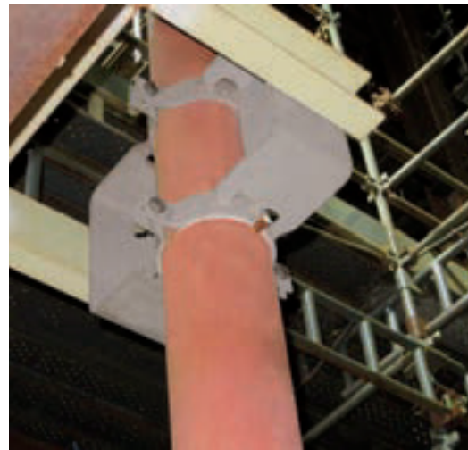
Rohrlagerung (Typ 49 .. .. G2P)
