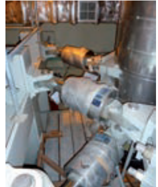
Sicherung von Rohrleitungen mit Stoßbremsen Typ 30
