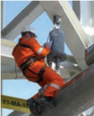
Kontrolle einer Halterung
