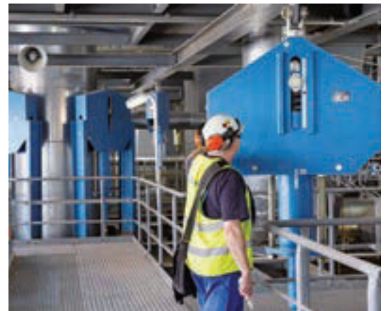
Inspection sur site d'un support constant
