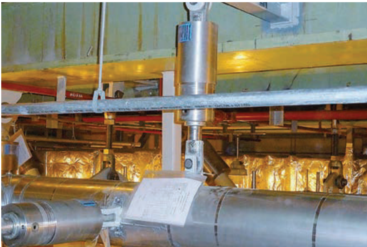
Sécurisation de la tuyauterie par des DAB Type 30 et des colliers dynamiques Type 36
