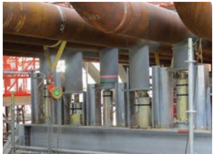
Chandelles Type 58 pour tuyauteries horizontales en guidages avec Supports Variable à charge posée Type 29
