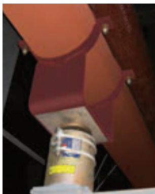
Contre-plaque en inox sous un patin Type 49, plaque de glissement pour haute température et support à charge posée Type 29
