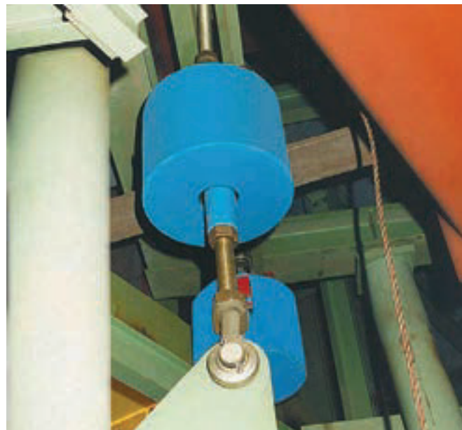
Support variable Type 22 avec chape taraudée Type 61
