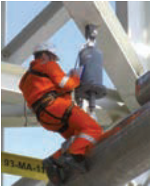
Contrôle d'un support
