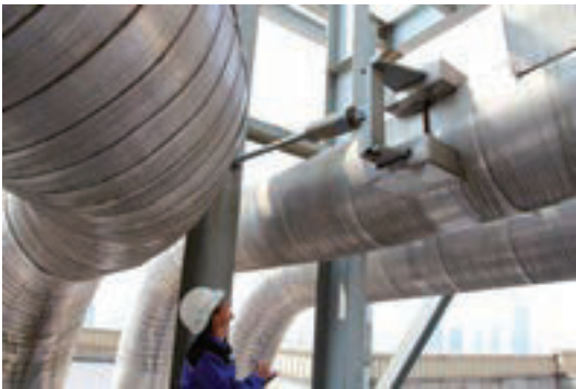
Contrôle de supports dans une installation
