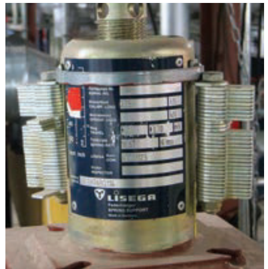
Type 29 avec fixation des clés de blocage
