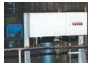
Armoire de commande d'un support constant assisté
