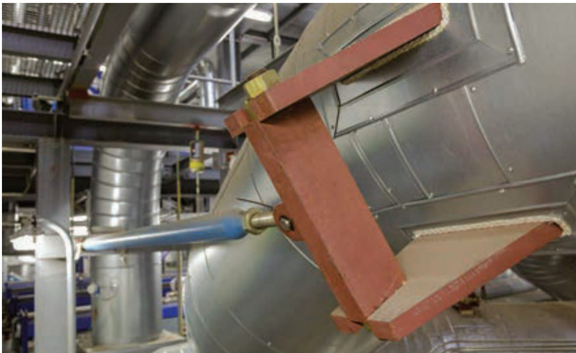
Blocage axial sur tuyauterie horizontale avec bras articulés Type 39 et colliers Type 34
