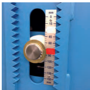
Escala de desplazamiento con marcas de posición en frío/en caliente
