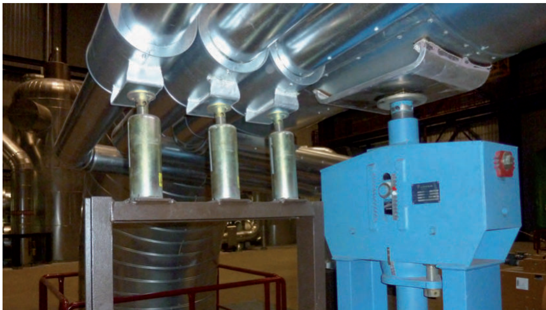
Uso típico de placas deslizantes bajo patines con abrazadera
