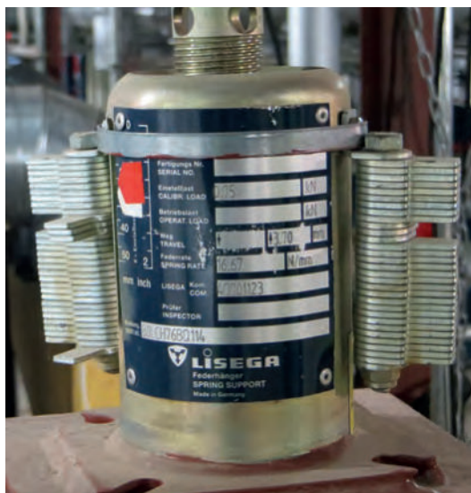
Tipo 29 con dispositivos de bloqueo acoplados
