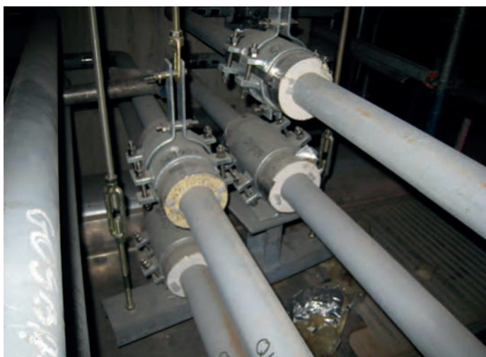
Tuberías sujetas en posición mediante soportes criogénicos
