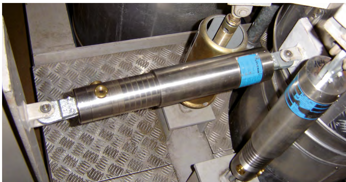
スナバー タイプ 30の取付け例
