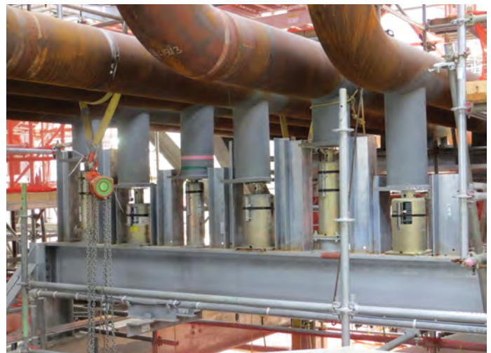
スターション タイプ 58 水平配管のガイドとしてタイプ 29スプリングサポートと一緒に使用
