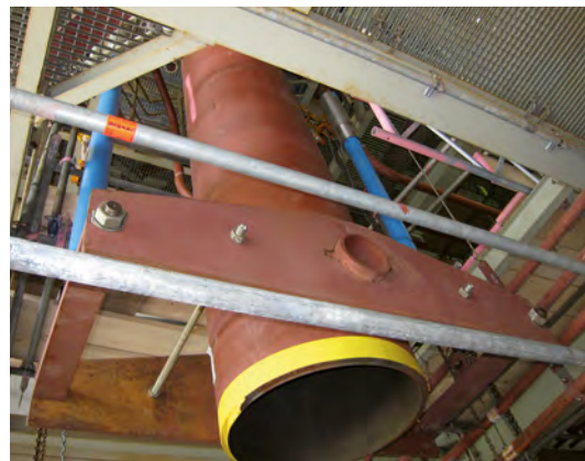
スナバーに接続した 位置決め装置付きのタイプ 34
