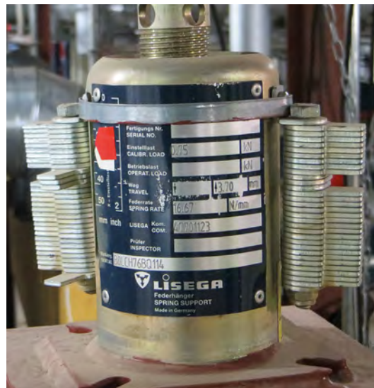
ロック装置を取付けた状態のタイプ 29
