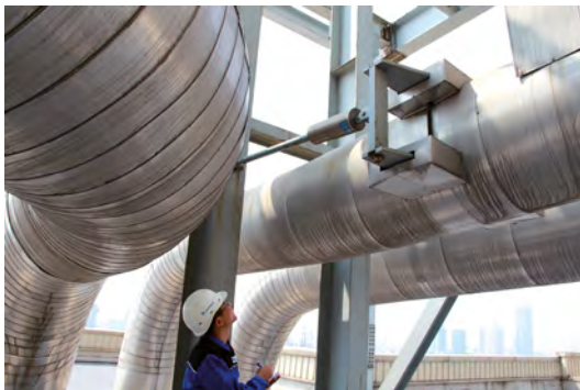
プラントでのサポートの点検
