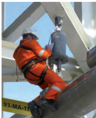
パイプサポートの点検
