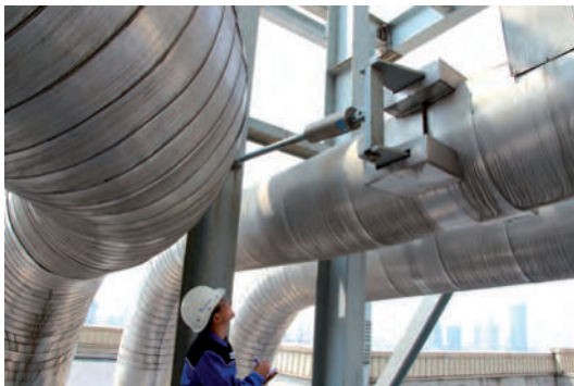
プラントでのサポートの点検
