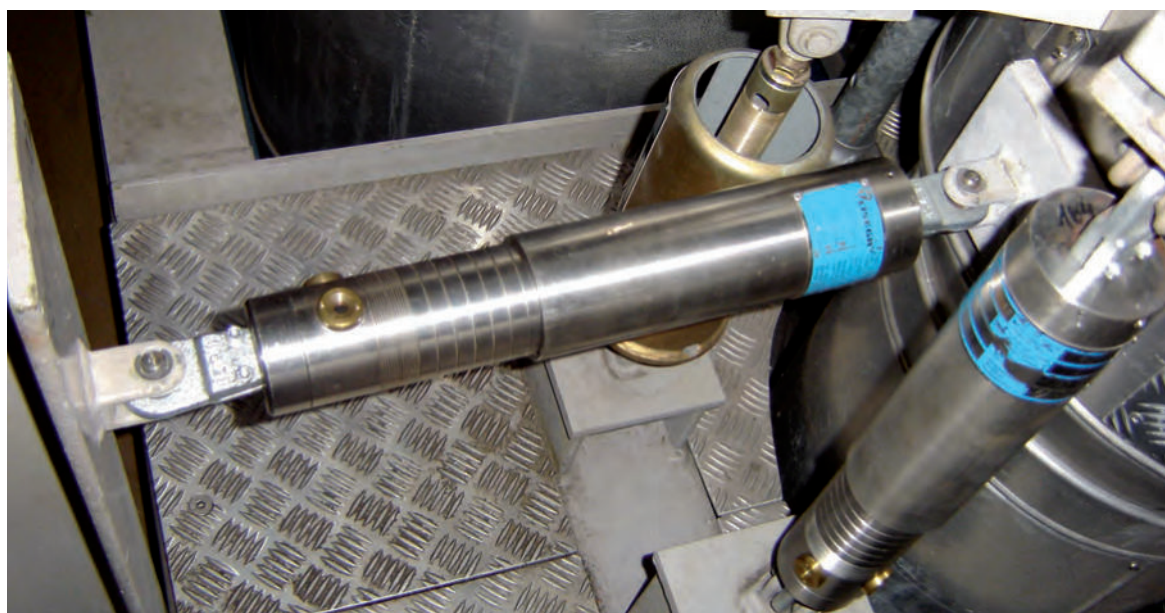
スナバー タイプ 30の取付け例
