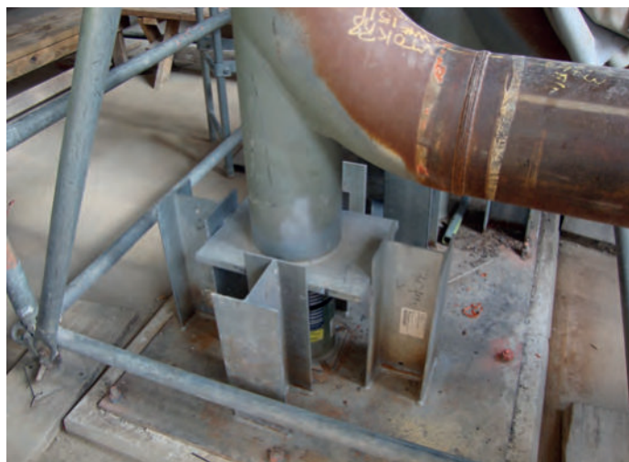
エルボ用スタンション タイプ 58 X-Y方向のモーメントフリーのストップとしてタイプ 29スプリングサポートと一緒に使用
