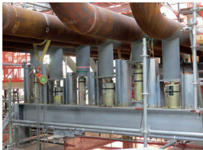
スタンション タイプ 58 水平配管のガイドとしてタイプ 29スプリングサポートと一緒に使用
