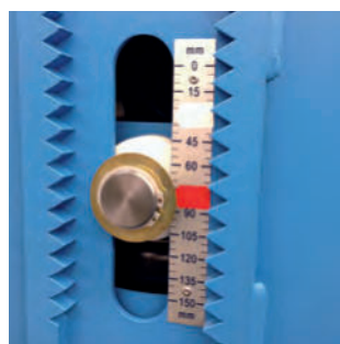
冷間時／運転時位置ラベルを貼ったトラベルスケール
