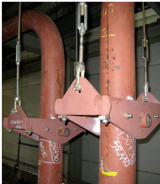
これらの標準化された製品はLISEGAモジュールシステムの一部を構成し、荷重と接続部の互換性を保証しています。
