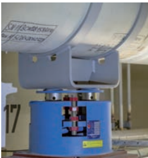
Rohrlager Typ 49 und Federstütze Typ 28 mit Gleitplatten
