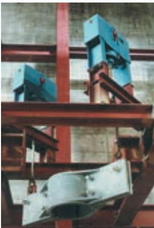
Unterstützung eines Vertikalstranges mit Sonderkonstruktion vom Typ 45
