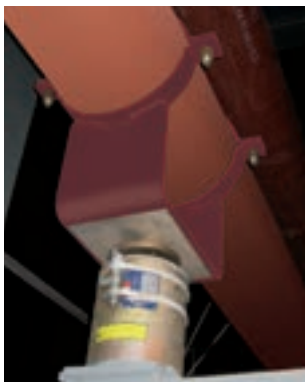
Edelstahl-Gleitblech unter Rohrlager Typ 49, Hochtemperatur-Gleitplatte und Federstütze Typ 29
