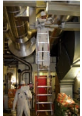
Visuelle Kontrolle von Stoßbremsen
