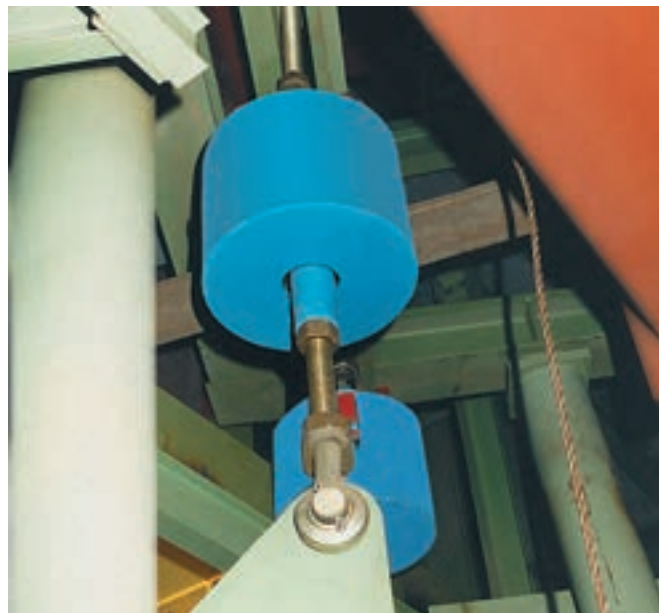
Federhänger Typ 22 mit Gewindebügel Typ 61 montiert
