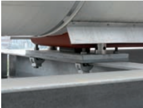
Rohrlager Typ 49 auf Gleitplatte, mit Klemmverbindung zum Stahlbau
