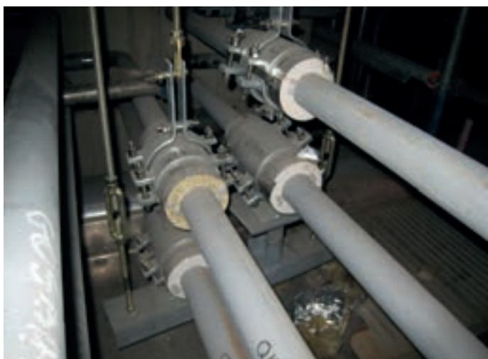
Halterung von Rohren mit kälteisolierten Unterstüzungen
