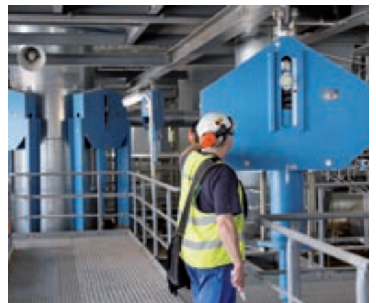
Einbauinspektion eines Konstanthängers
