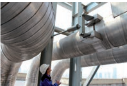
Kontrolle von Halterungen in der Anlage
