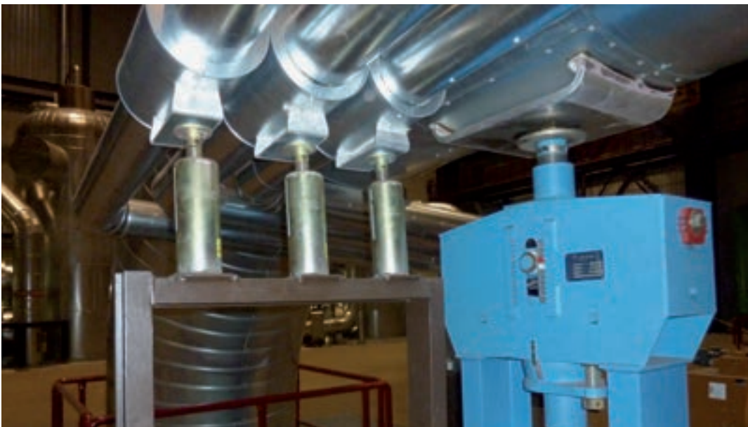
Typische Anwendung von Gleitelementen unter Rohrlagern
