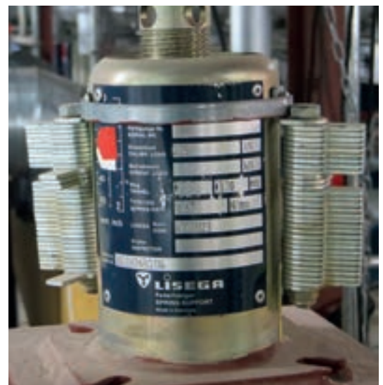
Typ 29 mit Befestigung der Blockierungen
