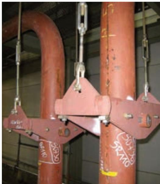
Ces éléments standardisés font partie intégrante du système modulaire LISEGA garantissant ainsi la compatibilité des raccordements et des charges.
