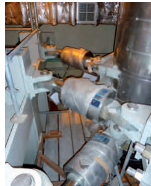
Крепление трубопроводов с ударными стопорами типа 30
