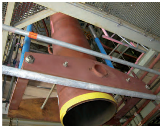
Тип 34 с ударными стопорами и устройствами для фиксации положения
