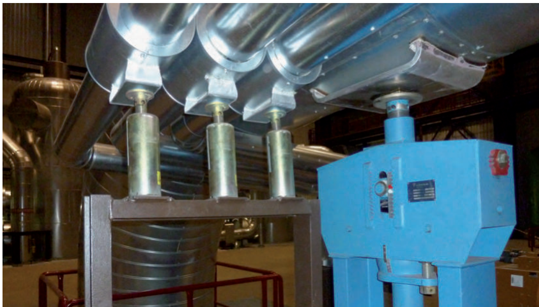
Стандартное использование скользких подложек для хомутовых опор
