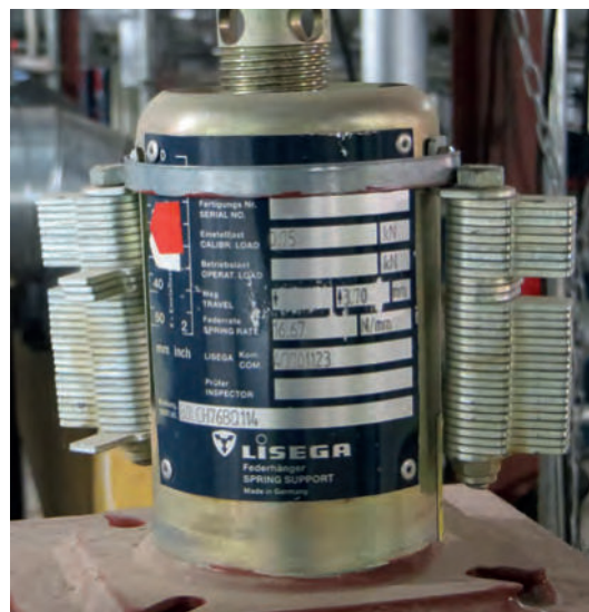
Тип 29 с присоединенными блокировочными устройствами
