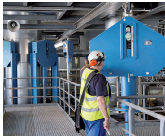
Контроль в процессе монтажа подвески постоянного усилия
