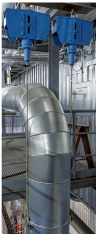
Подвеска постоянного усилия на угольной электростанции
