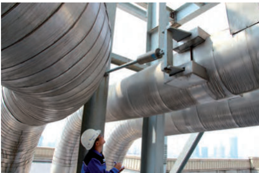
Проверка опор на электростанции
