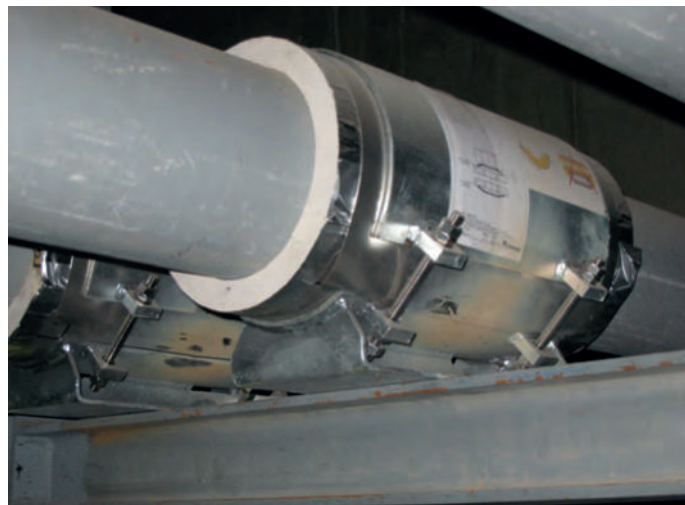
Низкотемпературная изолированная опора типа 56
