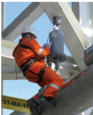
Регулирование опоры трубопровода
