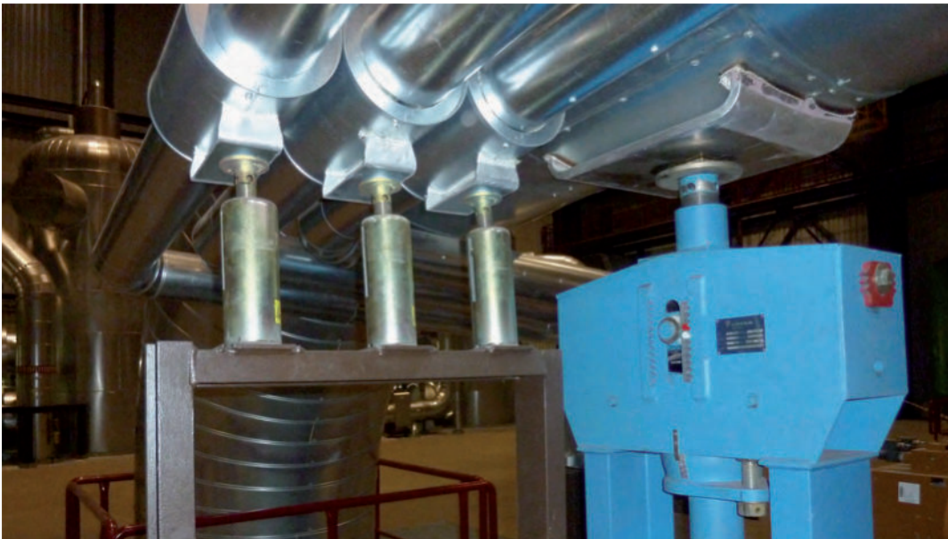
Стандартное использование скользящих подложек для хомутовых опор
