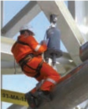
Contrôle d'un support
