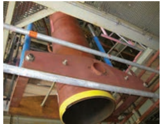
Type 34 avec DAB et maintien en position
