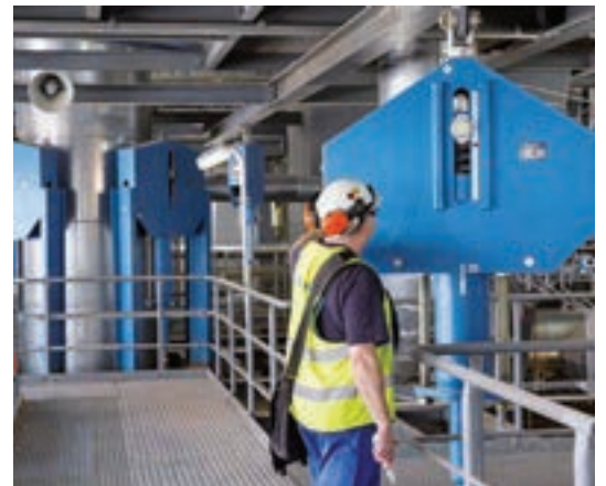
Inspection sur site d'un support constant
