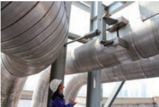
Contrôle de supports dans une installation
