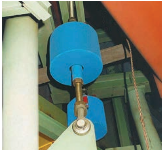
Support variable Type 22 avec chape taraudée Type 61
