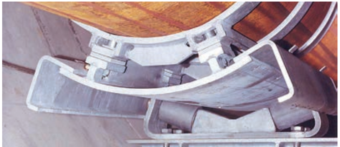
Selle spéciale Type 54 avec supports à double rouleaux cylindriques Type 53 et anti-soulèvement Type 55
