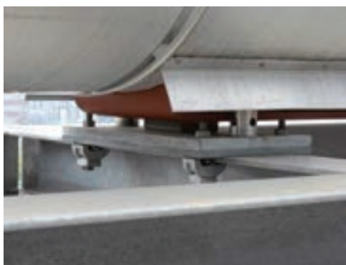
Patin Type 49 avec appui glissant et clamé sur la charpente en acier
