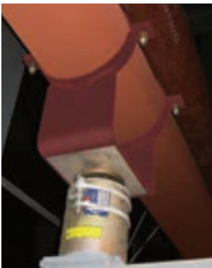
Contre-plaque en inox sous un patin Type 49, plaque de glissement pour haute température et support à charge posée Type 29
