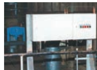
Armoire de commande d'un support constant assisté
