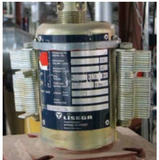
Type 29 avec fixation des clés de blocage
