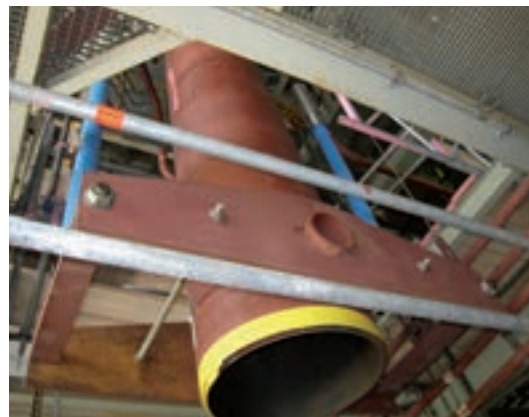
Typ 34 mit Stoßbremsen und Lagesicherung
