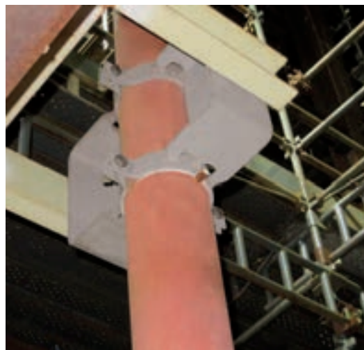
Rohrlagerung (Typ 49 .. .. G2P)
