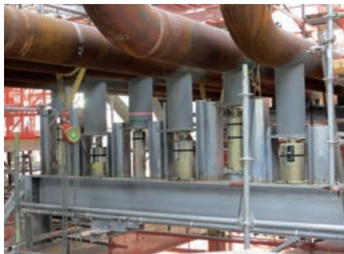
Rohrstützen Typ 58 für horizontal verlaufende Rohrleitungen als Führungen mit Federstützen Typ 29
