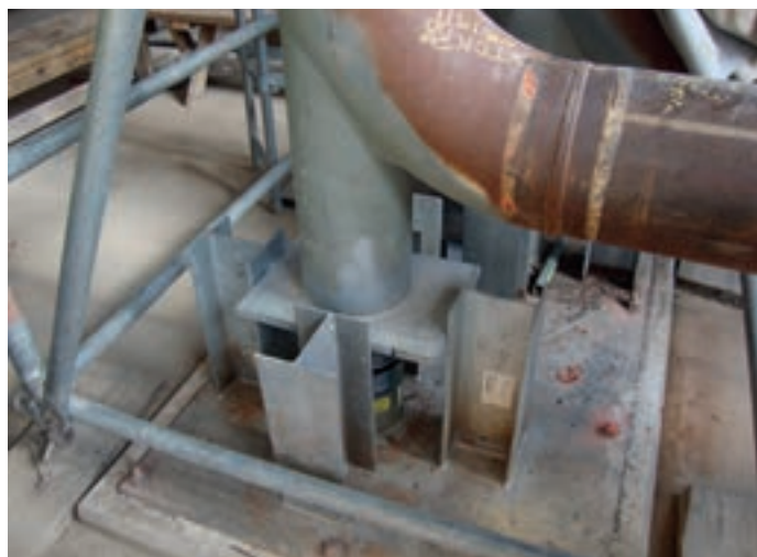
Rohrstütze Typ 58 für Rohrbogen als momentfreier Stopp in X-Y-Richtung mit Federstütze Typ 29
