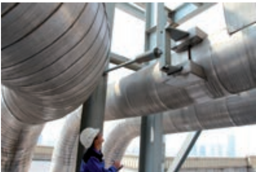
Kontrolle von Halterungen in der Anlage
