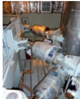
Sicherung von Rohrleitungen mit Stoßbremsen Typ 30
