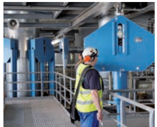
Einbauinspektion eines Konstanthängers
