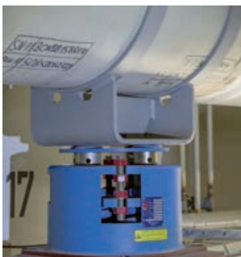
Rohrlager Typ 49 und Federstütze Typ 28 mit Gleitplatten
