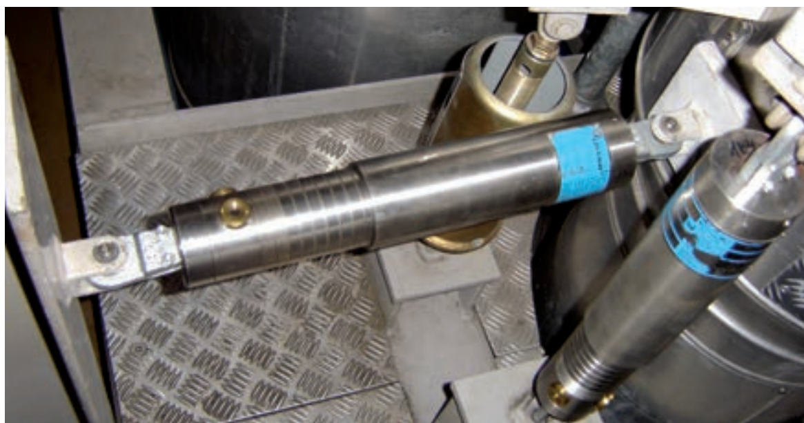
Einsatz von Stoßbremsen Typ 30
