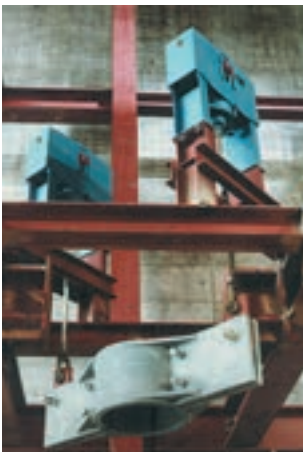
Unterstützung eines Vertikalstranges mit Sonderkonstruktion vom Typ 45
