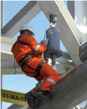
Contrôle d'un support
