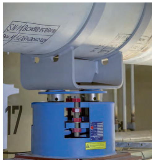
Patin Type 49 et support à charge posée Type 28 avec un appui glissant
