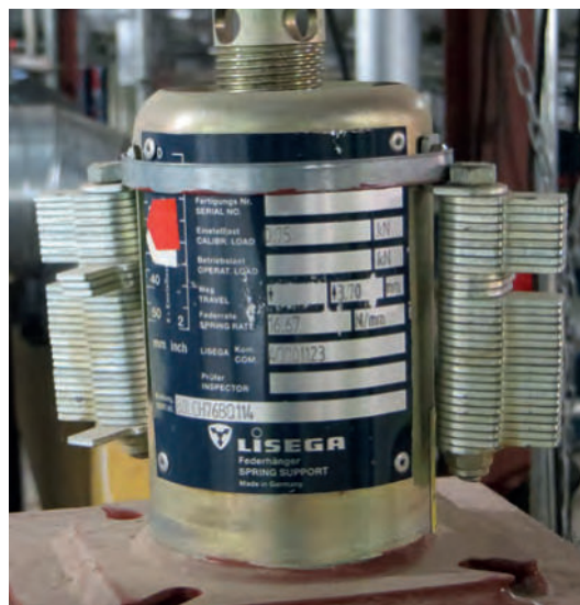
Type 29 avec fixation des clés de blocage
