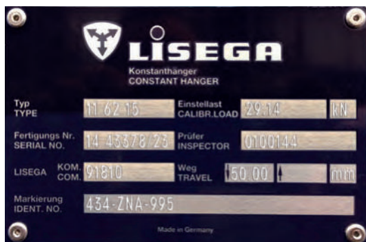
Plaque signalétique avec données de service frappées
