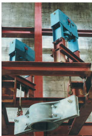
Reprise d'un élément vertical par un collier spécial Type 45
