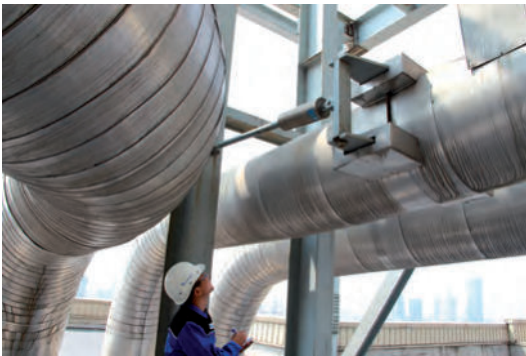
Contrôle de supports dans une installation
