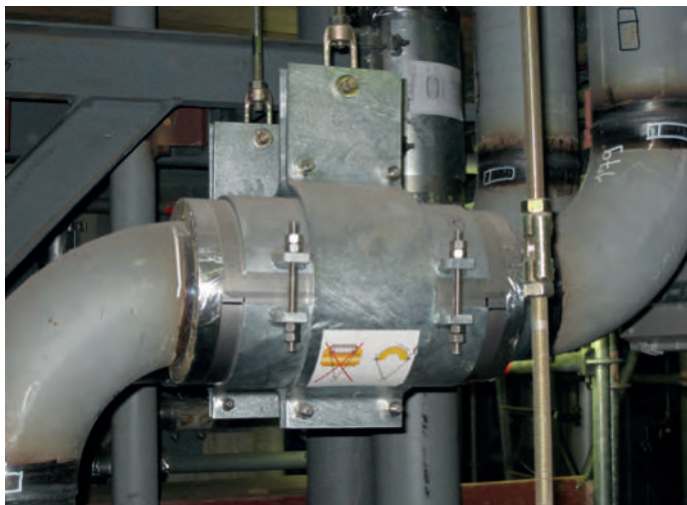
Supportage avec colliers cryogéniques
