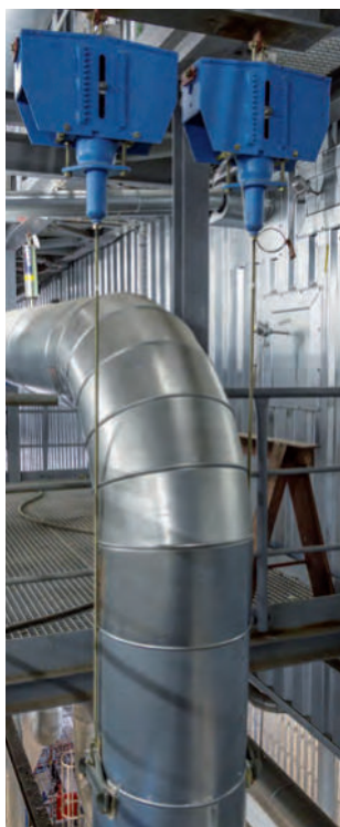
Support Constant installé dans une Centrale thermique
