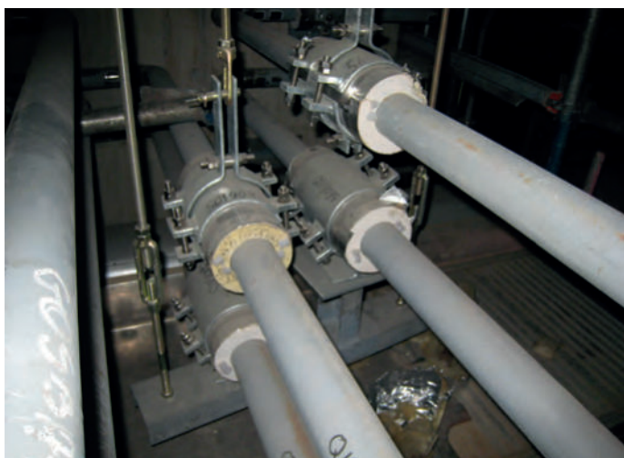
Supportage de tuyauterie avec appuis cryogéniques
