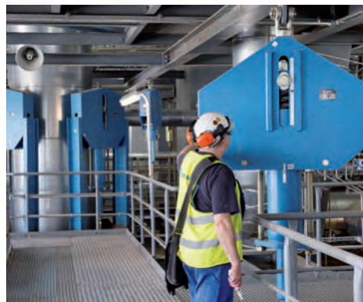
Inspection sur site d'un support constant
