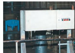
Armoire de commande d'un support constant assisté
