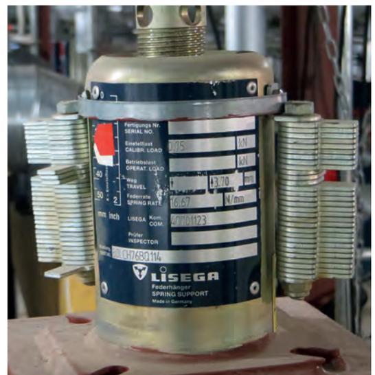
Type 29 avec fixation des clés de blocage
