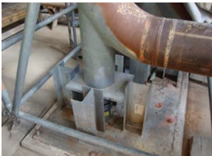
Chandelle Type 58 pour coude en guidage X-Y avec Support Variable à charge posée Type 29
