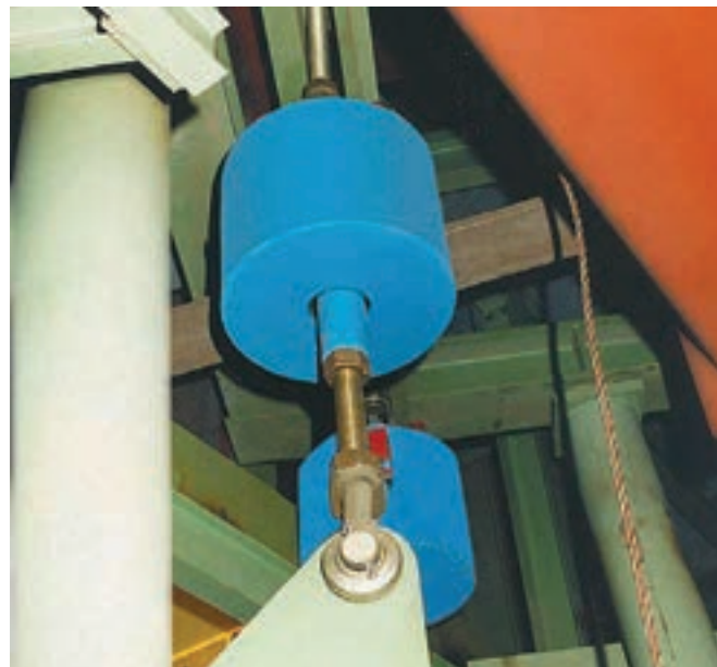
Support variable Type 22 avec chape taraudée Type 61
