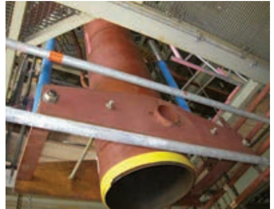
Type 34 avec DAB et maintien en position
