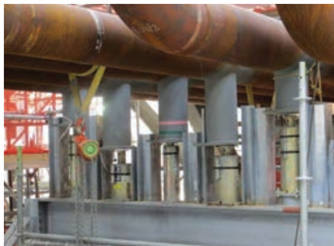
Chandelles Type 58 pour tuyauteries horizontales en guidages avec Supports Variable à charge posée Type 29
