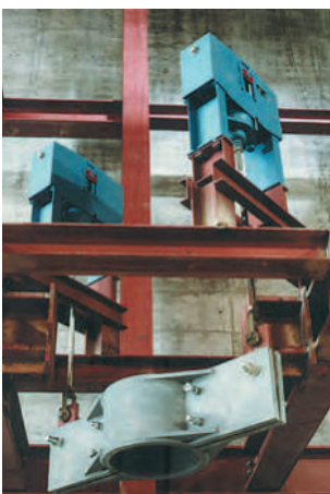
Unterstützung eines Vertikalstranges mit Sonderkonstruktion vom Typ 45
