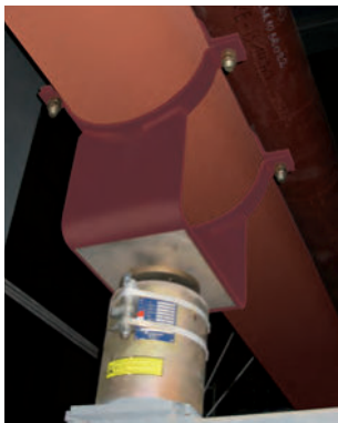
Edelstahl-Gleitblech unter Rohrlager Typ 49, Hochtemperatur-Gleitplatte und Federstütze Typ 29
