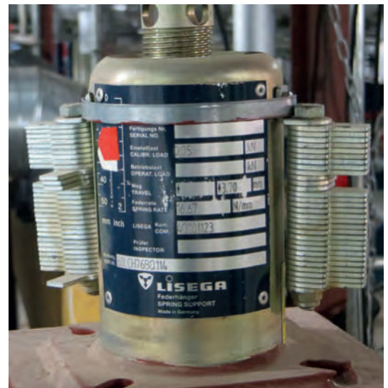
Typ 29 mit Befestigung der Blockierungen
