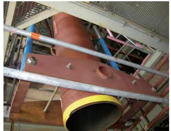
Typ 34 mit Stoßbremsen und Lagesicherung
