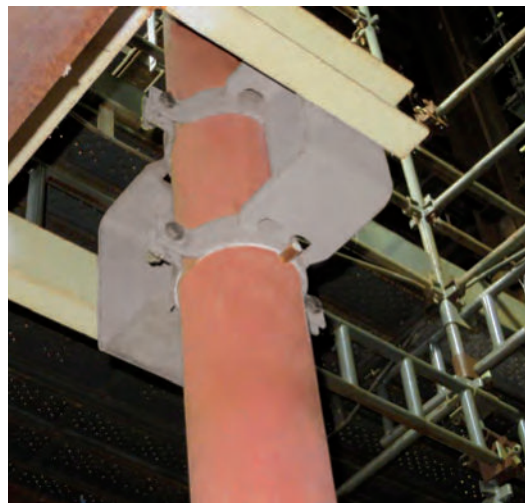
Rohrlagerung (Typ 49 .. .. G2P)
