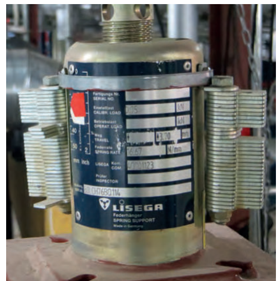
Typ 29 mit Befestigung der Blockierungen
