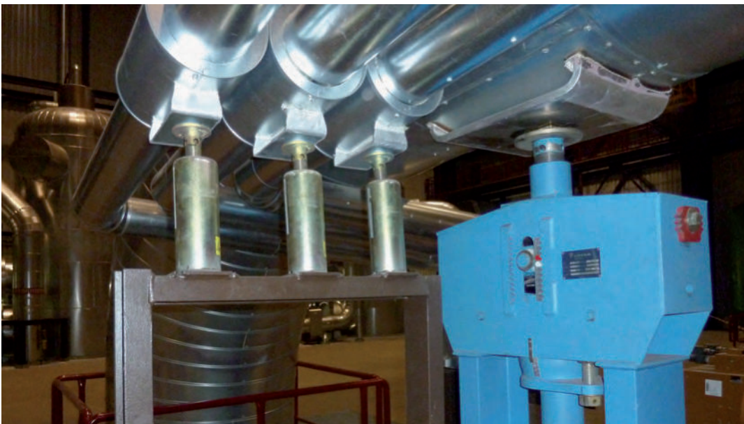
Typische Anwendung von Gleitelementen unter Rohrlagern
