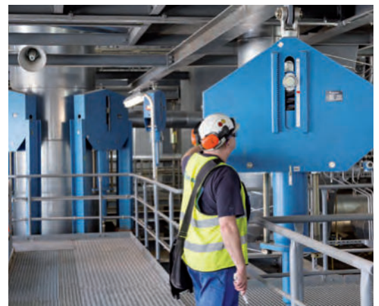
Einbauinspektion eines Konstanthängers
