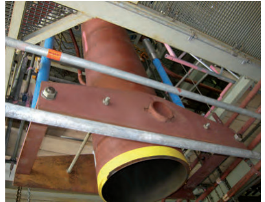
Typ 34 mit Stoßbremsen und Lagesicherung
