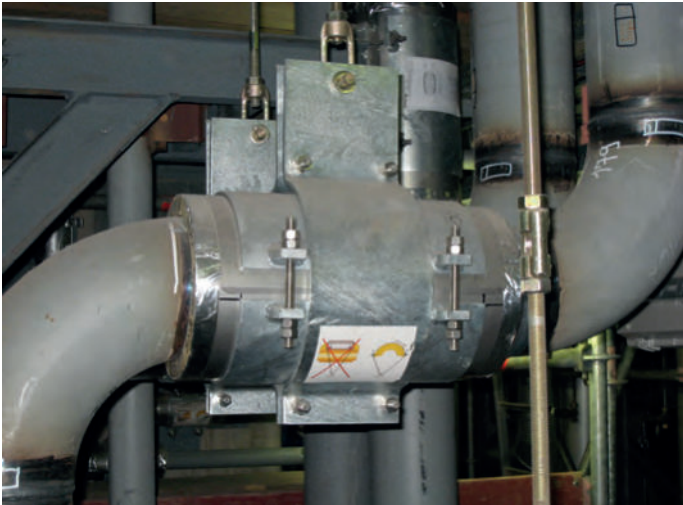
Abhängung mit kryogenen Rohrschellen
