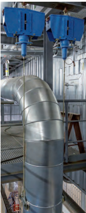
Konstanthänger in einem Kohlekraftwerk
