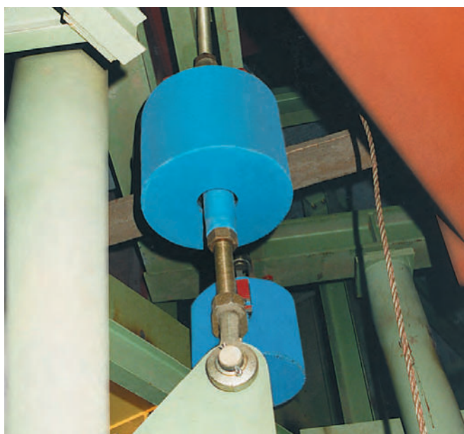
Federhänger Typ 22 mit Gewindebügel Typ 61 montiert
