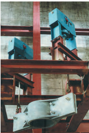
Unterstützung eines Vertikalstranges mit Sonderkonstruktion vom Typ 45
