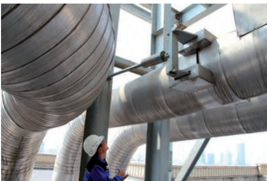
Kontrolle von Halterungen in der Anlage
