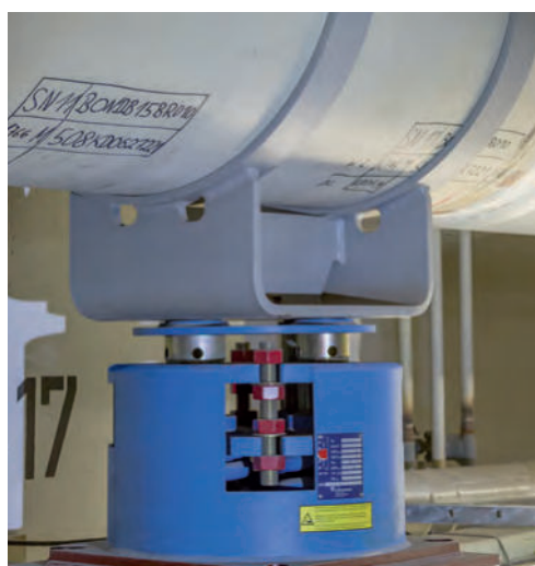
Rohrlager Typ 49 und Federstütze Typ 28 mit Gleitplatten
