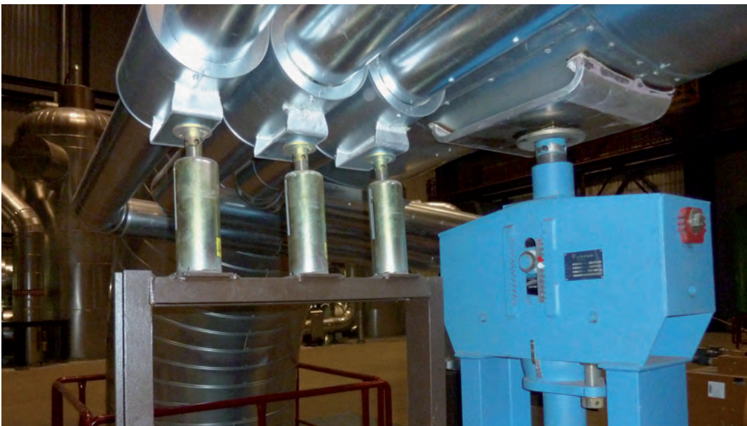
Typische Anwendung von Gleitelementen unter Rohrlagern
