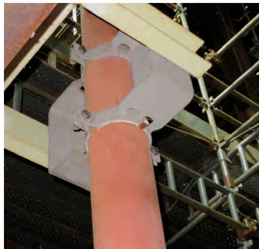
Rohrlagerung (Typ 49 .. .. G2P)
