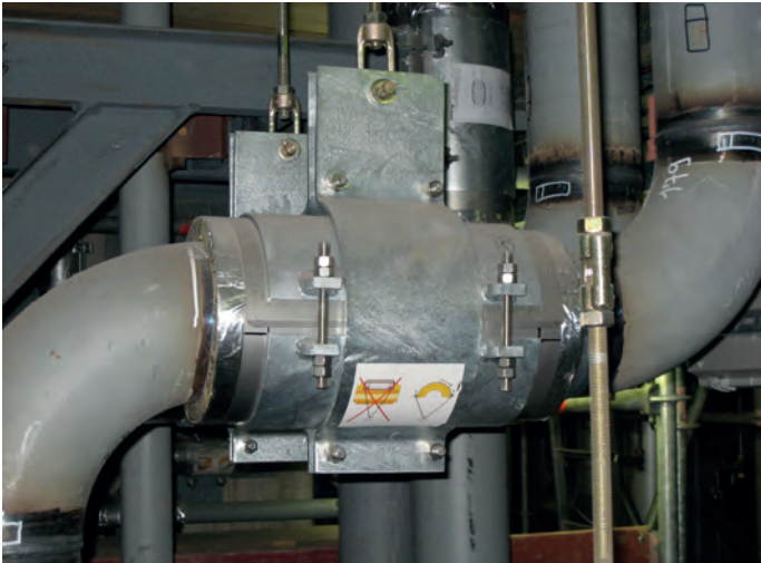
Abhängung mit kryogenen Rohrschellen
