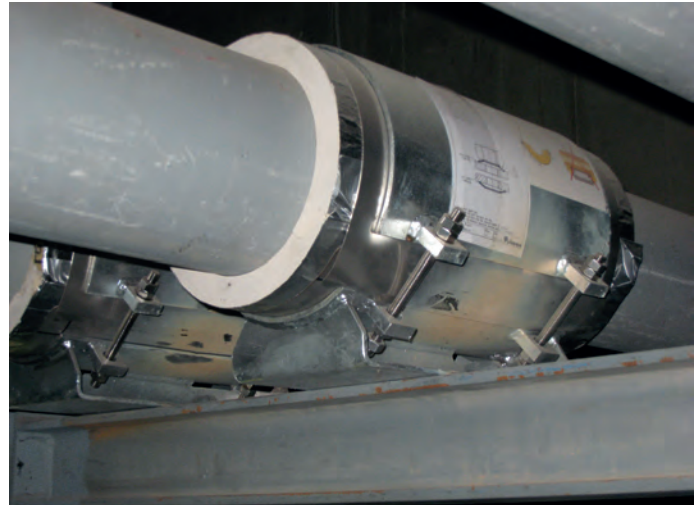
Kälteisoliertes Rohrlager Typ 56
