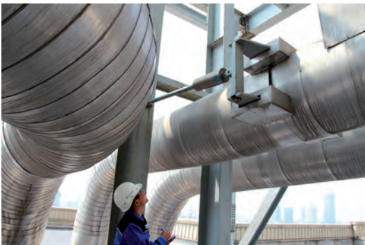
Kontrolle von Halterungen in der Anlage
