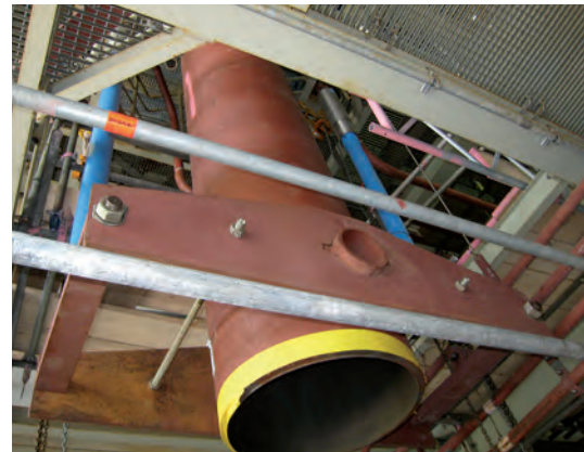
Typ 34 mit Stoßbremsen und Lagesicherung
