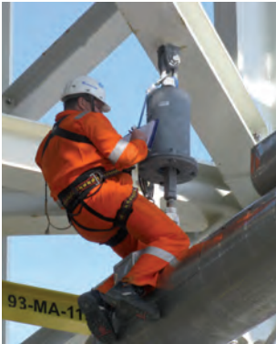
Kontrolle einer Halterung
