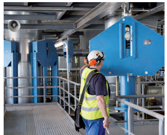
Einbauinspektion eines Konstanthängers
