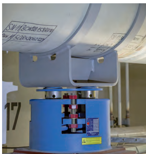
Rohrlager Typ 49 und Federstütze Typ 28 mit Gleitplatten
