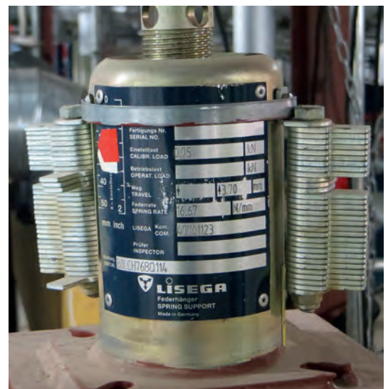
Typ 29 mit Befestigung der Blockierungen
