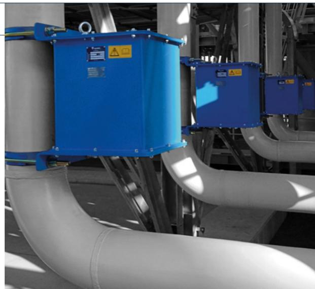
Optimale Minderung von Schwingungsamplituden durch geeignete Tilgersysteme
