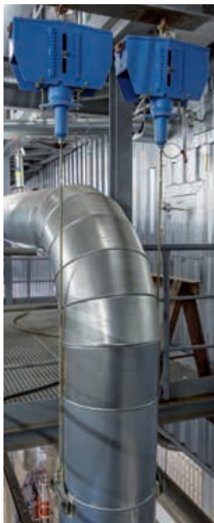
Подвеска постоянного усилия на угольной электростанции
