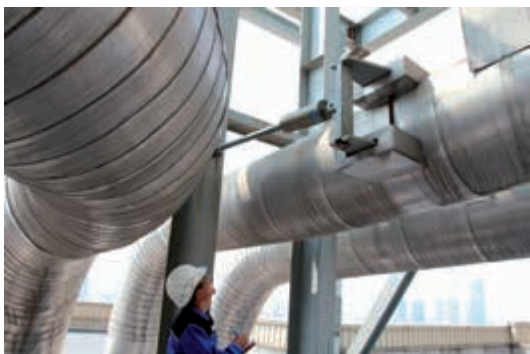
Проверка опор на электростанции
