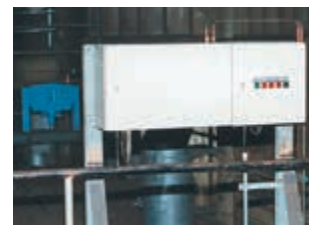
Шкаф управления сервоподвесок
