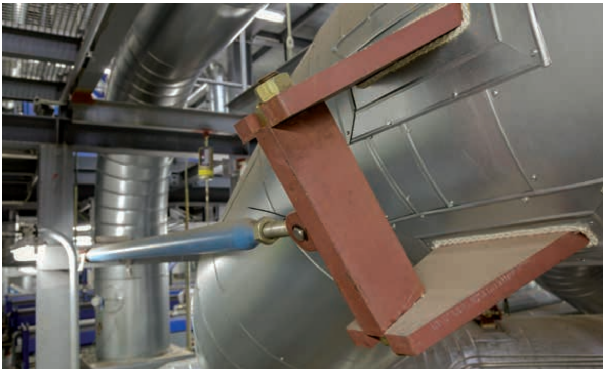
Горизонтальный осевой упор с жесткими распорками типа 39 и трубным хомутом типа 34
