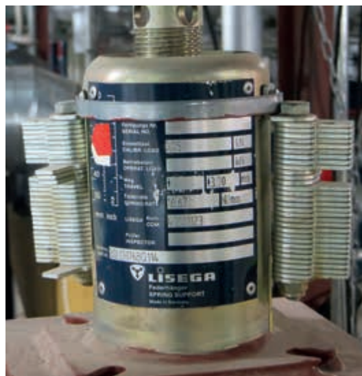
Тип 29 с присоединенными блокировочными устройствами
