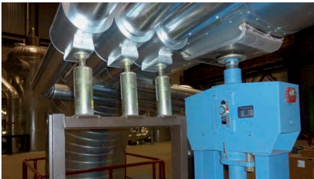
Стандартное использование скользящих подложек для хомутовых опор
