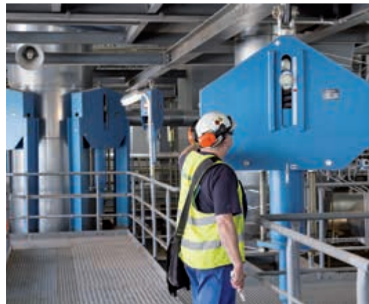
Контроль в процессе монтажа подвески постоянного усилия
