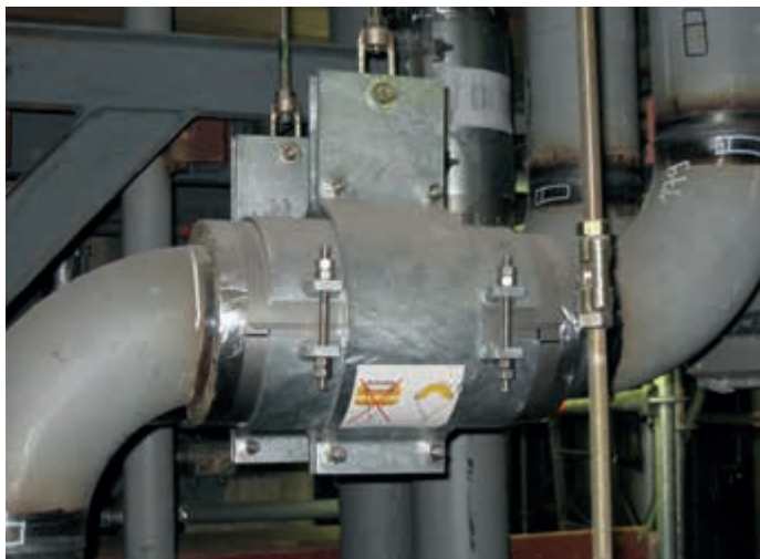
Подвешивание с помощью низкотемпературных трубных хомутов
