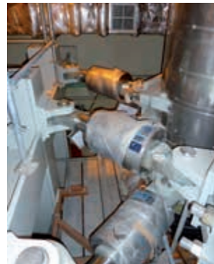
Крепление трубопроводов с ударными стопорами типа 30
