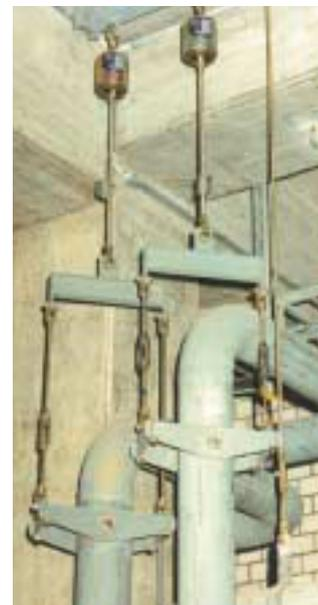
Эти стандартизированные компоненты являются неотъемлемой частью модульной системы LISEGA, и совместимость соединений и нагрузок обеспечивается, соответственно.
