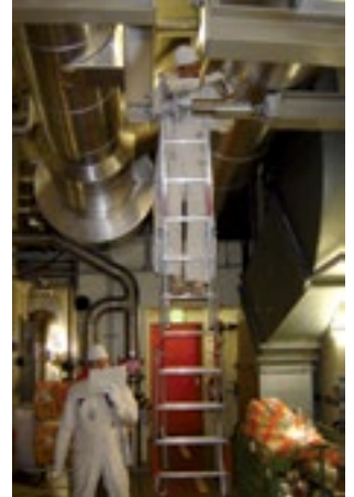
Visuelle Kontrolle von Stoßbremsen
