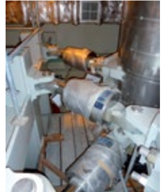
Sicherung von Rohrleitungen mit Stoßbremsen Typ 30
