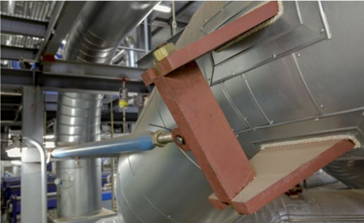
Horizontal liegender axialer Stopp mit Gelenkstreben Typ 39 und Rohrschelle Typ 34
