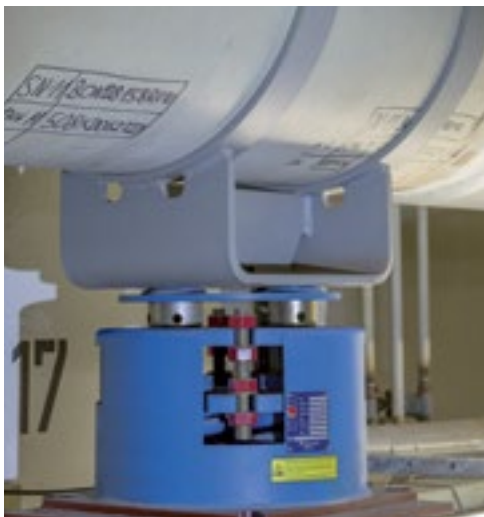
Rohrlager Typ 49 und Federstütze Typ 28 mit Gleitplatten
