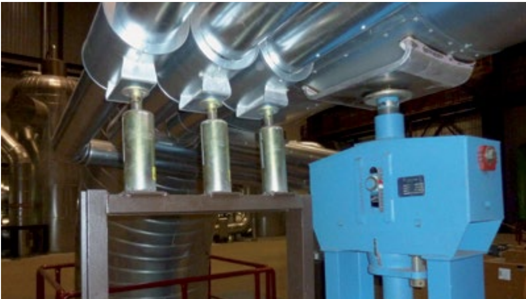
Typische Anwendung von Gleitelementen unter Rohrlagern
