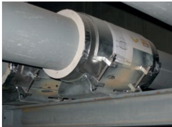
Kälteisoliertes Rohrlager Typ 56
