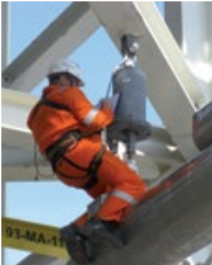
Kontrolle einer Halterung
