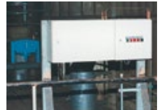
Schaltschrank eines Servohängers
