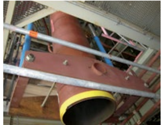
Typ 34 mit Stoßbremsen und Lagesicherung
