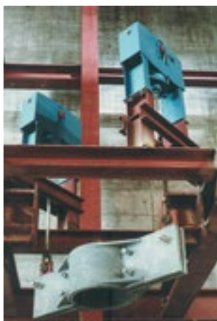
Unterstützung eines Vertikalstranges mit Sonderkonstruktion vom Typ 45
