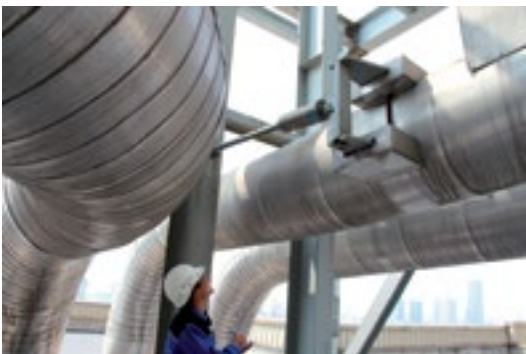
Kontrolle von Halterungen in der Anlage
