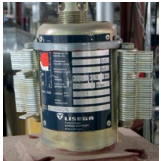
Typ 29 mit Befestigung der Blockierungen
