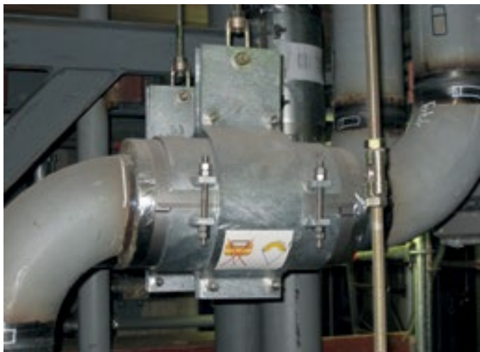
Abhängung mit kryogenen Rohrschellen
