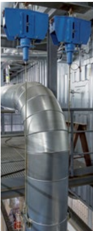
Konstanthänger in einem Kohlekraftwerk
