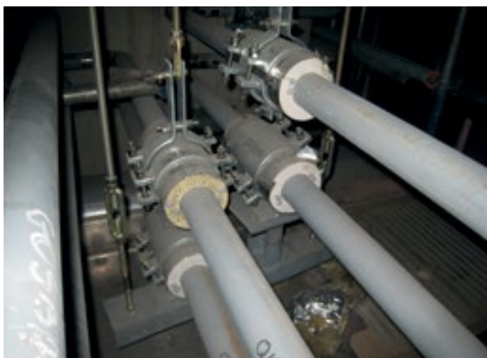
Halterung von Rohren mit kälteisolierten Unterstüzungen
