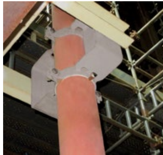
Rohrlagerung (Typ 49 ... -G2P)
