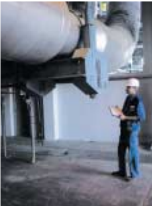
Kontrolle auf sachgerechte Montage
